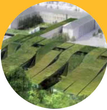
Rénovation du lycée Marcel Sembat Sotteville-les-Rouens
