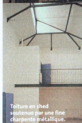
Toiture en shed soutenue par une fine charpente métallique.
