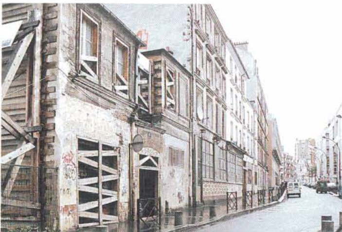
Rue des Panoyaux, vue de l'angle de la rue Duris.
